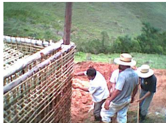
Figuras 4, 5 e 6. Técnica de construção em taipa de mão (pau a pique) e taipa de pilão
