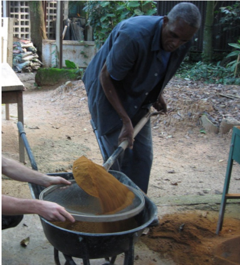
Figura 34. Peneiramento da terra a ser usada no compósito.
