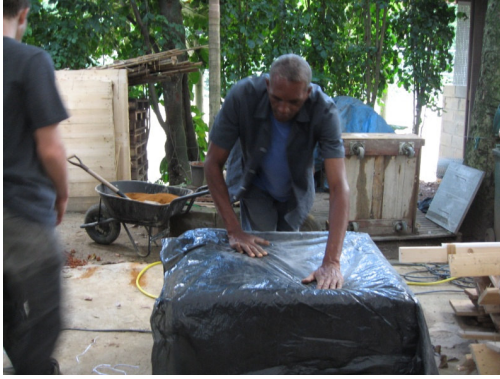
Figura 40. Preparo da mesa vibratória recebendo lona de proteção.
