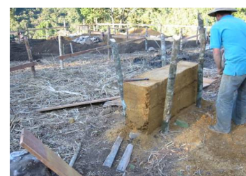
Figuras 4, 5 e 6. Técnica de construção em taipa de mão (pau a pique) e taipa de pilão
