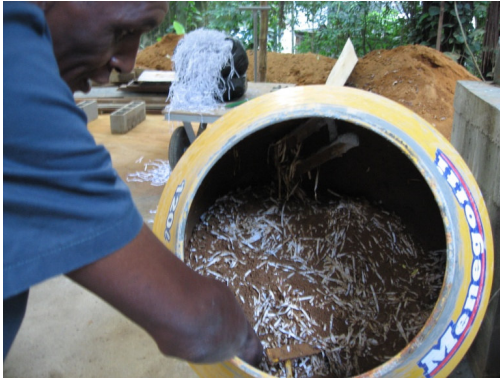
Figura 37. Uso de betoneira para mistura do compósito
