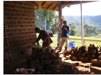
Figuras 1, 2 e 3 .Preparo do barro, confecção de tijolos e construção de paredes na técnica de adobe
