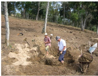
Figuras 1, 2 e 3 .Preparo do barro, confecção de tijolos e construção de paredes na técnica de adobe
