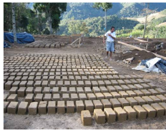
Figuras 1, 2 e 3 .Preparo do barro, confecção de tijolos e construção de paredes na técnica de adobe
