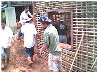
Figuras 4, 5 e 6. Técnica de construção em taipa de mão (pau a pique) e taipa de pilão
